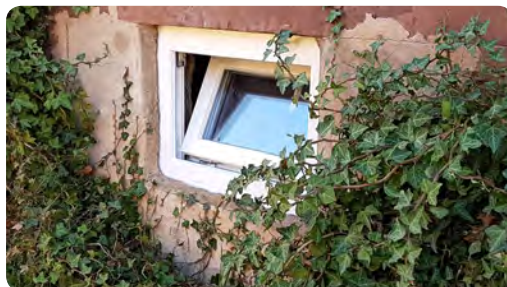
Fenêtre de la cave de la mairie (photo M.V.)
