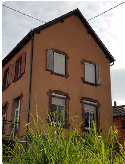
Les nouveaux volets à l'étage (Photo M.V.)
