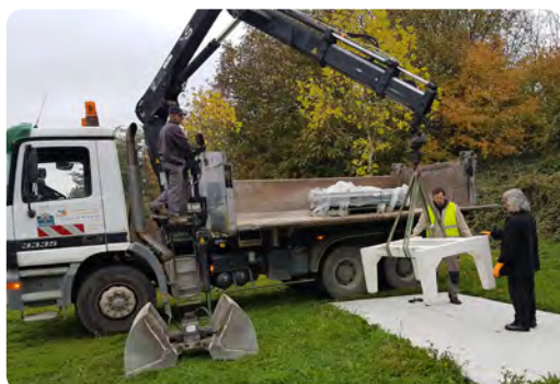
Installation de la table de ping-pong (M.V.)
